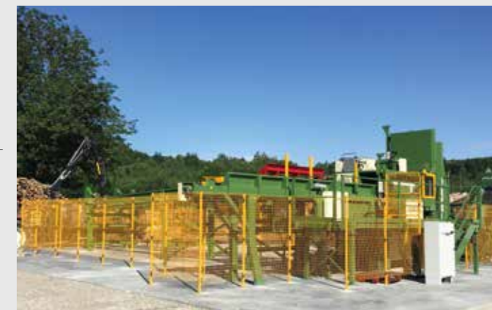
Vallas de seguridad para delimitar la zona de trabajo
