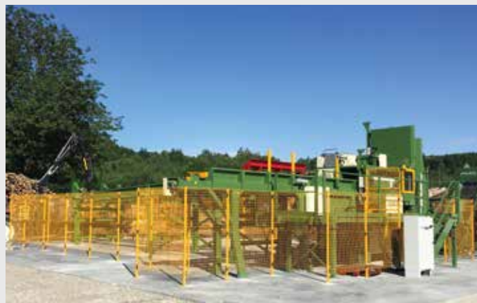
Recinzioni di sicurezza per delimitare area di lavoro
